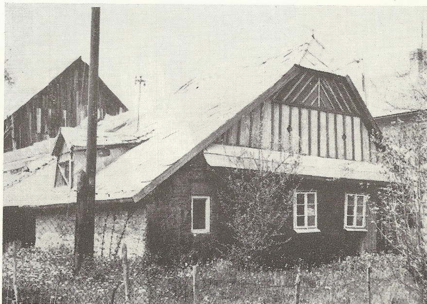
Dosud stávající typický vysočinský roubený domek čp. 88 se skládanou lomenicí, podlomením a mansardičkou na dolním Jeníkově majitele Františka Laštůvky, postavený počátkem minulého století.
