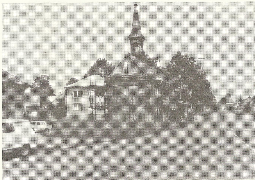
Kaple postavená v r. 1900 — při pokrývání střechy plechem v r. 1986.
