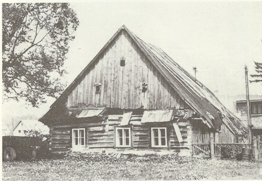
Jedna z posledních typických horských chalup v Jeníkově postavená začátkem minulého století čp. 92, několik let neobydlena a určena k demolici.
