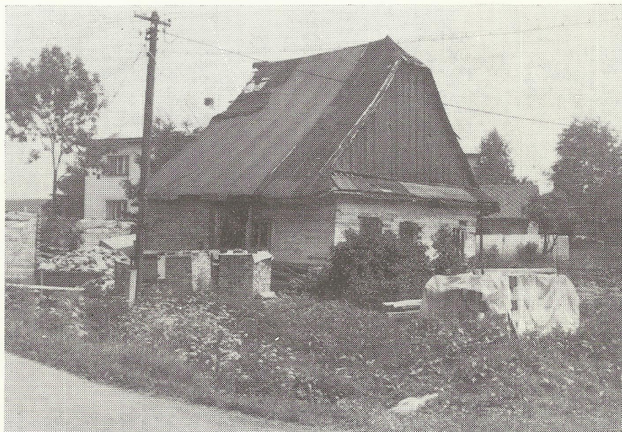
Domek čp. 19 při demolici, kde bydlel a pracoval mistr kolářský Josef Pech.
